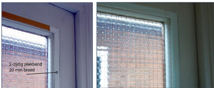
Figuur 5. Bevestig het 20 mm brede plakband langs de dagmaat. Maak de Acrylplaat goed schoon. Verwijder de beschermstrook en druk de op maat gesneden Acrylplaat stevig op het plakband.
