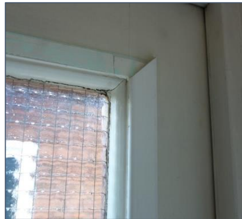
Figuur 7. Plaats de hoeklat precies langs de dagkant van de Acrylplaat en teken de andere zijde af waar het verstek moet komen.
