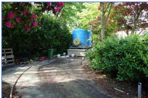
Figuren 13. Na afloop moet de tuin weer opnieuw aangelegd. Zonder brede toegang kan ook tijdelijk de heg opzij geplaatst worden. Bij diepe boringen (150-200 m) is er meer werkruimte nodig dan bij de ondiepe boringen van 50 m diep van Geheco.
