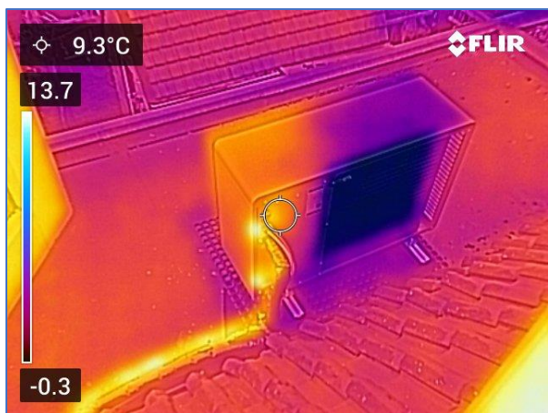
Figuren 35. Kleine (hybride) WP op een dakje. Wanneer de CV eruit gaat komt hier een tweede kleine WP ernaast. De leiding mag wel wat beter geïsoleerd zijn. Deze WP staat op nog geen meter van de burens vandaan. Het geluid wordt door de dakpannen gereflecteerd. Dit kan bezwaarlijk zijn als de burens op de etage slapen.
