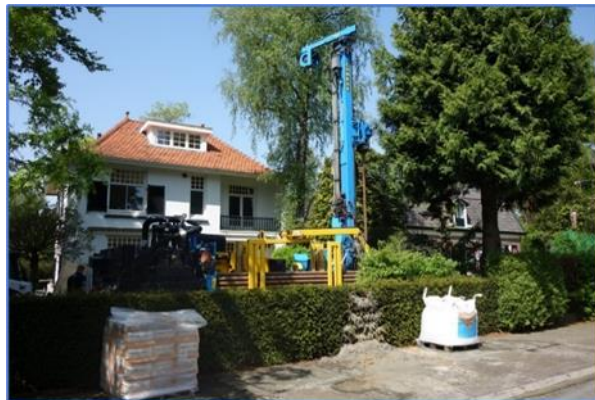
Figuren 12. Vrachtwagens voor de boorinstallatie en opgerichte boorinstallatie.
