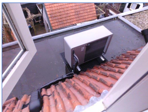
Figuren 35. Kleine (hybride) WP op een dakje. Wanneer de CV eruit gaat komt hier een tweede kleine WP ernaast. De leiding mag wel wat beter geïsoleerd zijn. Deze WP staat op nog geen meter van de burens vandaan. Het geluid wordt door de dakpannen gereflecteerd. Dit kan bezwaarlijk zijn als de burens op de etage slapen.
