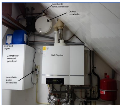
Figuur 15. Bij een gas-CV wordt het water uit het tussen-opslagvat verder verwarmd tot 65°C en is dus legionella-vrij.
