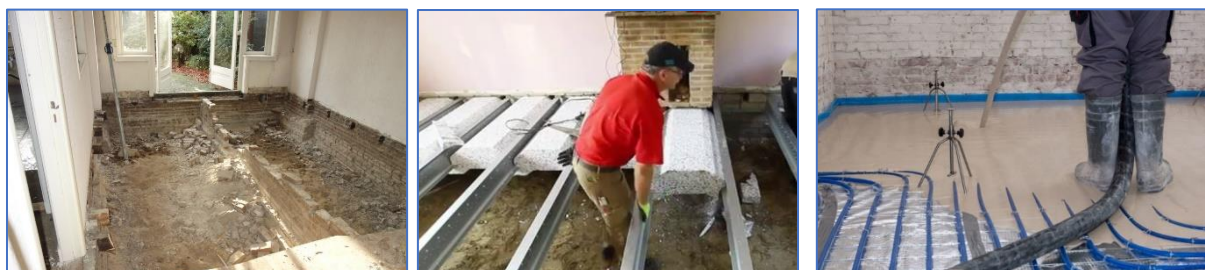
Figuren 2. Het verhogen van de bestaande vloer of het aanleggen van een geheel nieuwe vloer met LTV houdt veel werk in, maar met een betere gebouwisolatie en radiatorventilatoren kan ook goed verwarmd worden. 24
