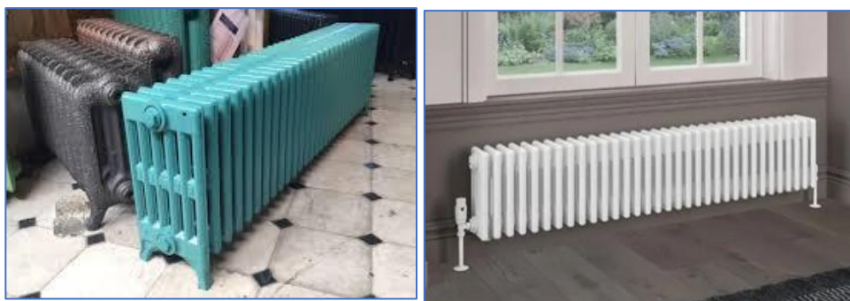
Figuren 32. Oude radiatoren hebben een groter watervolume dan plaatradiatoren. In monumenten kunnen deze radiatoren ook voor de verwarming dienst blijven doen wanneer de muren binnenzijde na-geïsoleerd zijn.
