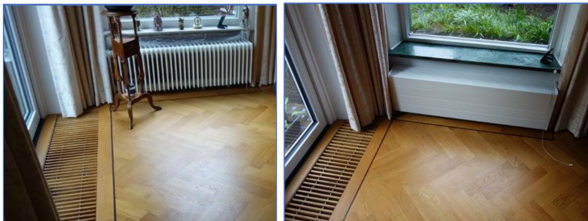
Figuren 1. Een LTV-vloerverwarming is niet altijd nodig. Wanneer u bijvoorbeeld een mooie vloer heeft, zou u die niet willen slopen om daar een LTV-vloerverwarming in/op te bouwen. Links . Oude situatie met oude radiator en een slecht werkende convectorbak.
