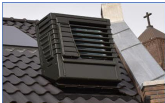
Figuren 48. WP units op een schuin dak en de aanvullende apparatuur op zolder.
