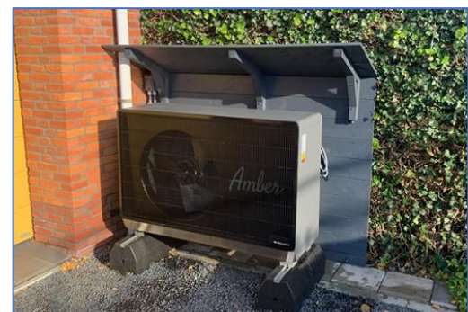
Figuur 38. WP tegen een heg met een geluidsscherm (Adler). De heg is de erfscheiding. Het geluidsscherm reflecteert het geluid de tuin in en verminderd geluidprojectie naar boven. De erfgrans van de burens aan de andere zijde van de tuin ligt minstens 6 m verder, waardoor daar de geluidsdruk minder zal zijn.
