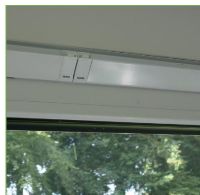
Figuren 29. Linksboven : Ventilatioerooster boven op het dubbel glas van terrasdeuren van buiten gezien.
