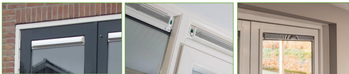
Figuren 29. Linksboven : Ventilatioerooster boven op het dubbel glas van terrasdeuren van buiten gezien.
