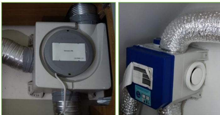
Figuren 13. Links. Oud model mechanische ventilator (pre-2000) op 220 Volt met relatief hoog stroomverbruik.
