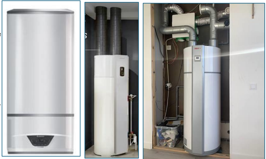
Figuren 30: Atag Lydos een 100 liter warmtepompboiler; Atlantic explorer 200 liter met luchtkanalen.
