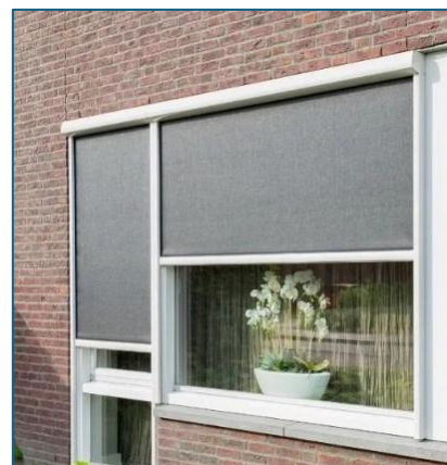
Figuur 8. Permanente screens buitenop. Er zijn verschillende modellen. Deze kunnen elektrisch bediend worden. Het doek kan op de duur ook vervangen worden. Verschillende soorten doek zijn beschikbaar zoals half licht-doorlatend. Het frame wordt op het kozijn bevestigd en kan op maat besteld worden.
