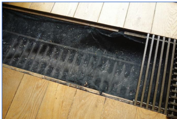
Figuur 7. Het netje boven de radiator blokkeert zowel de ingang van de koele lucht als de uitgang van de verwarmde lucht.
