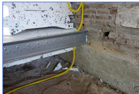
Figuur 17. Jaren 1930 woning zonder woonkamervloer. Betonnen draagstrook langs de fundering met stalen ⊥ balken met EPS broodjes/blokken. Daarover komt een druklaag en de LTV.
