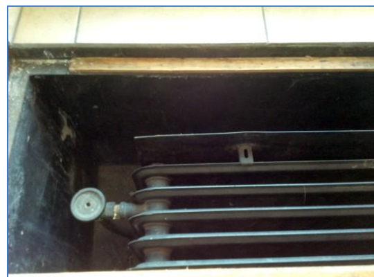
Figuur 15. Zwart geschilderde bak en zwart metalen scheidingsplaat. De zwart metalen scheidingsplaat absorbeert extra veel warmte en geleidt deze door naar de instroomkant, wat de luchtdoorstroming belemmert. De metalen plaat moet tweezijdig bekleed worden met radiatorfolie.
