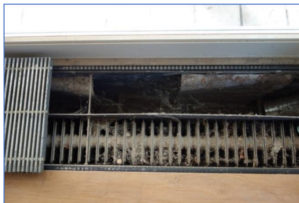
Figuur 6. Spinnenwebben en haren van huisdieren moeten ten minste vóór het verwarmingsseizoen verwijderd worden. Deze vormen een extra belemmering van de luchtdoorvoer.
