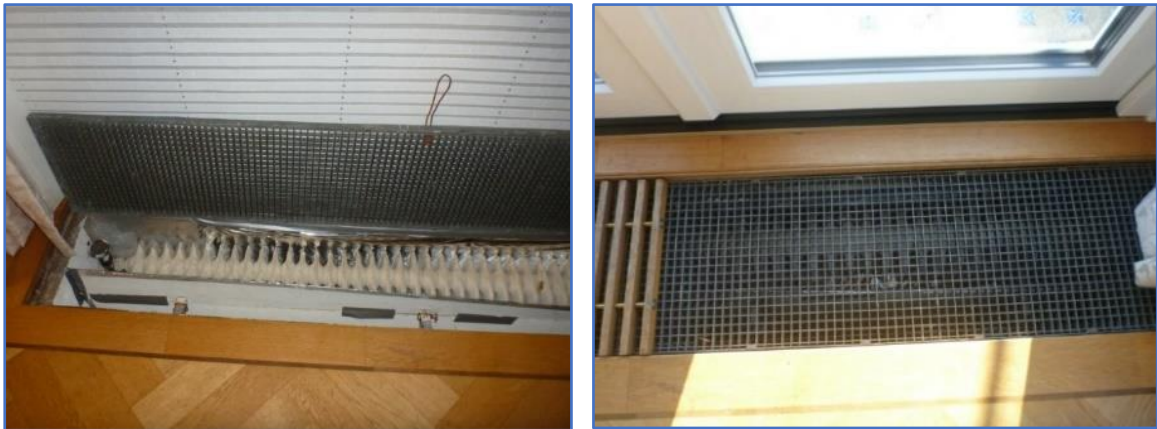
Figuren 14. Het houten rooster met de meeste opening verbetert de lucht circulatie. Een metalen rooster vermindert de luchtcirculatie omdat dit in haar geheel warm wordt, ook boven de inlaat.
