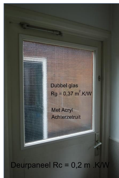
Figuur 10. Omdat het oppervlak van de rest van de deur veel groter is dan de glasruit alleen, verdient het aanbeveling om het slecht isolerende paneel aan de onderzijde ook nog te isoleren.
