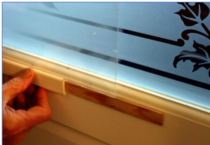
Figuren 11. Twee voorbeelden van montage van het ondersteuningslatje en de hoeklat.
