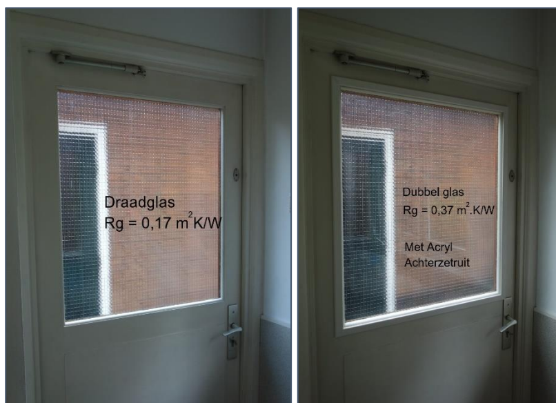
Figuren 2. Oude en nieuwe situatie. Toevoeging aan binnenzijde van heldere 2 mm Acrylplaat en luchtspace van 18 mm. Afgewerkt met een hoeklat.
