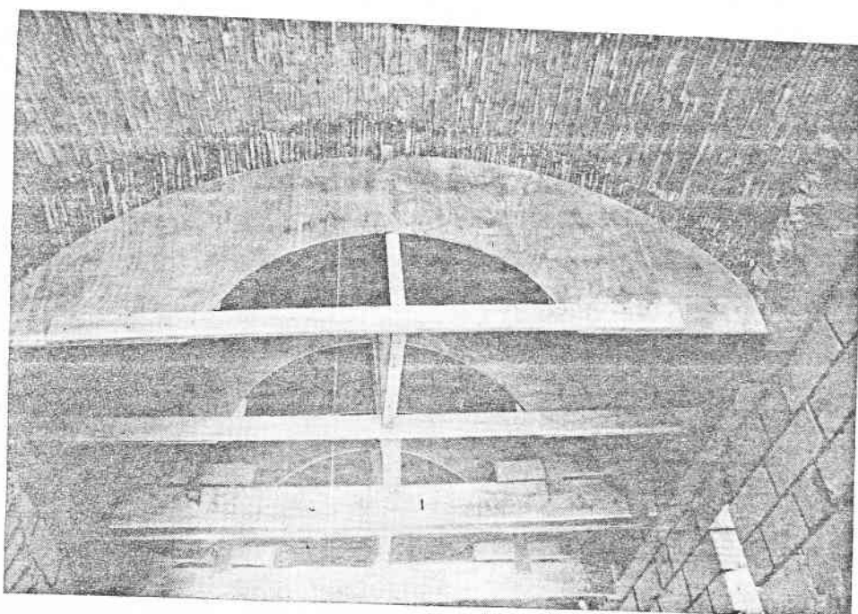
Photo 11 Vu à l'intérieur du coffrage
