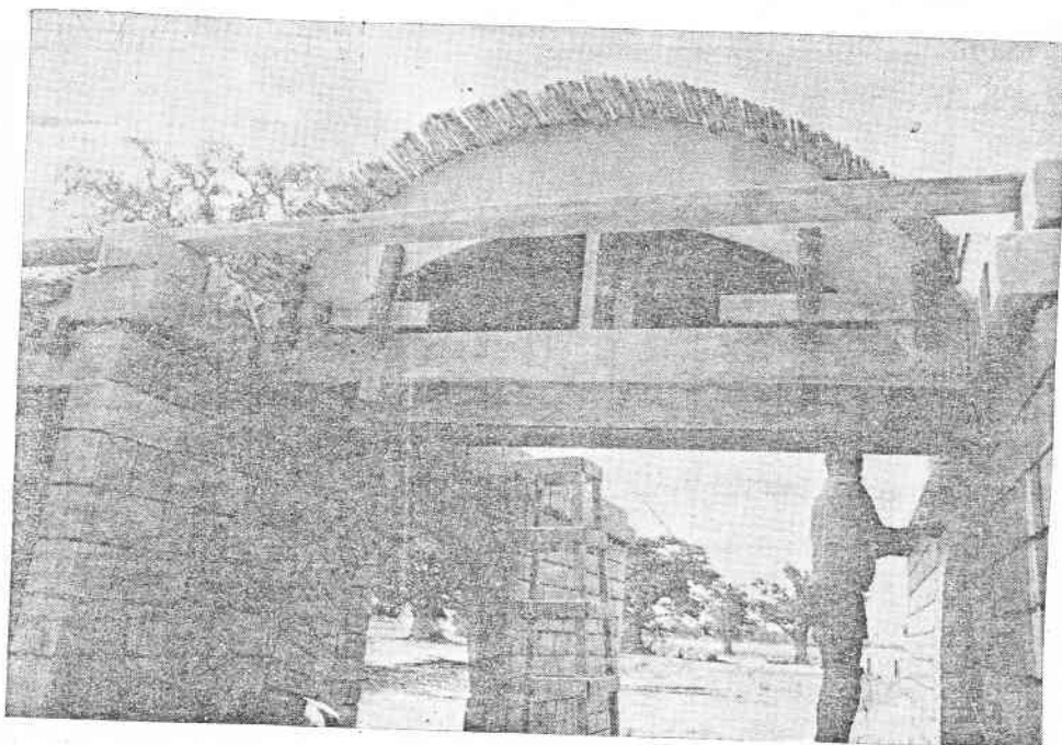
Photo 10 Le coffrage de la voûte est posé
