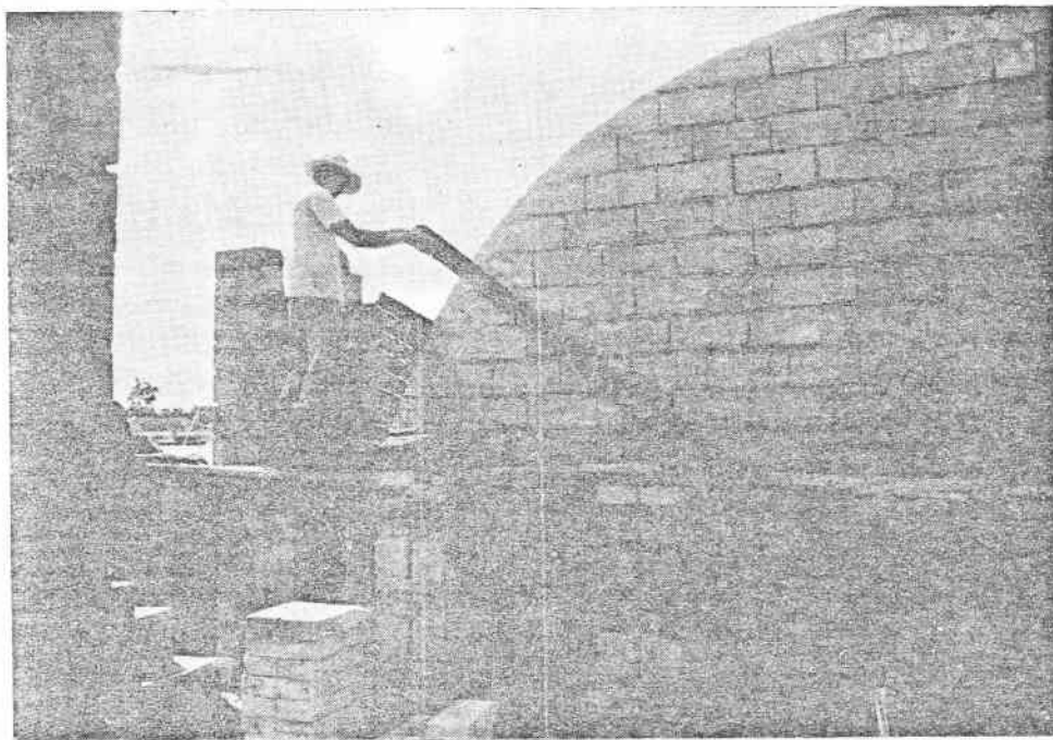
Photo 14 Construction de l'arche à l'aide d'un gabarit
