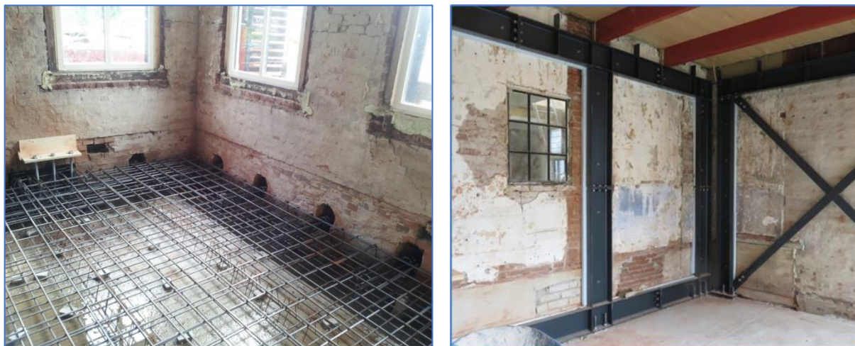
Figuren 117. Testwoning in Loppersum met volledige plaatfundering
