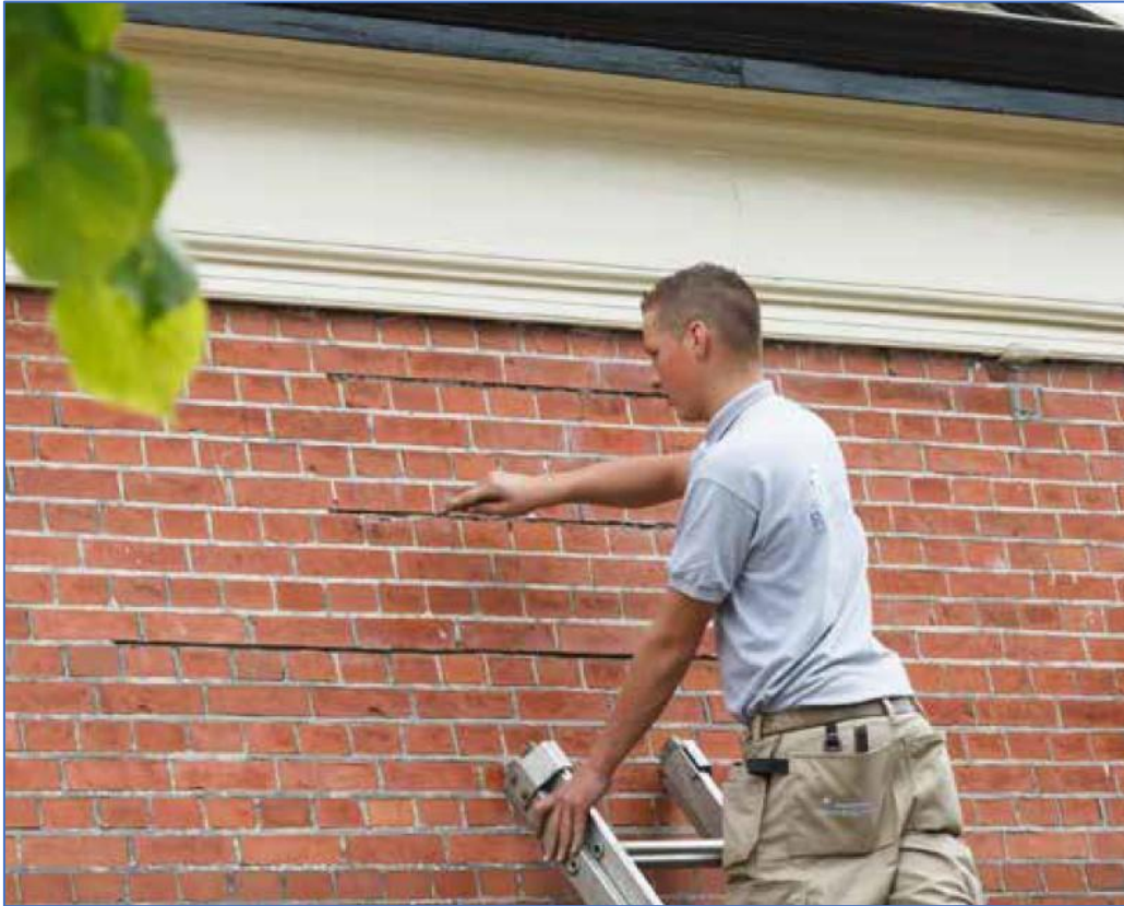
Figuur 123. Toepassing van de reparatie van een steensmuur met Helifix rvs wikkels. Bron NAM.
