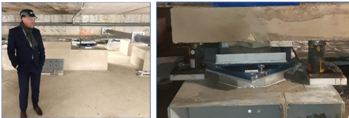
Figuren 110. Toegepast base-isolation onder het gemeentehuis Loppersum.
