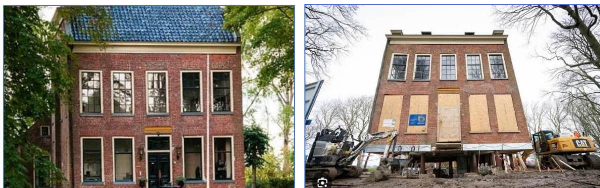
Figuren 112. Rijksmonument Borg Rusthoeve te Wirdum is op base-isolation gezet.
