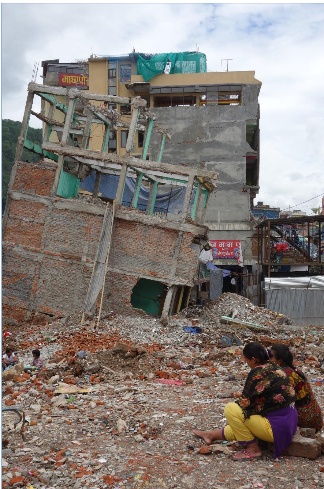
Figuur 88. Niet aardbevingsresistent want de begane grondetage is ingestort
