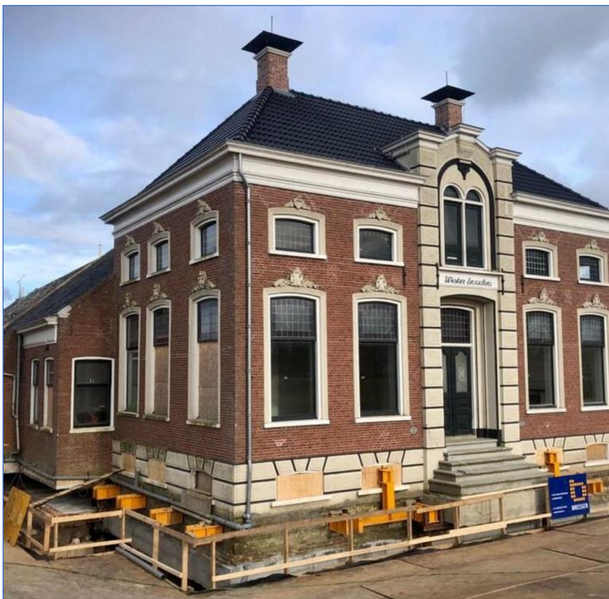
Figuur 47. Historische boerderij Garrelsweer werd op base-isolation gezet (E.f)
