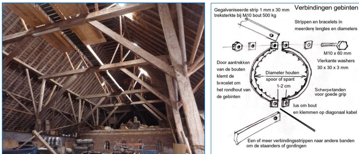
Figuren 114. Ringbanden (vierkante klemijzers) voor het verstijven van de grote schuur.
