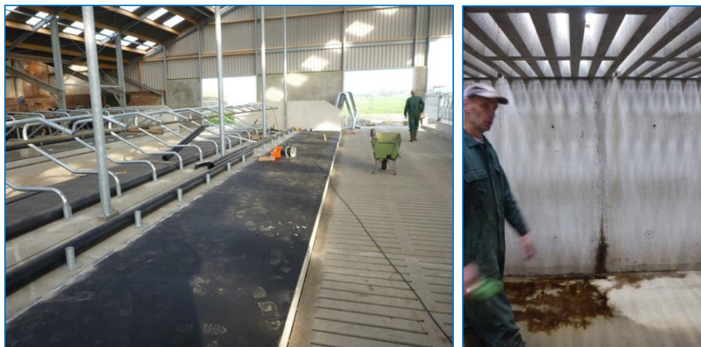
Figuren 2. Nieuwe stallen in aanbouw met open vloeren, met daaronder de lange gierkelders.
