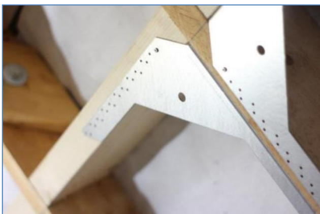
Figuren 9-43. Overzicht van een woonhuis opspanning. Door het aandraaien van een bout kan precies de afstand en de spanning van de diagonalen geregeld worden. Rechts. Hoek verbinding voor vernageling op gezaagde spantdelen.
