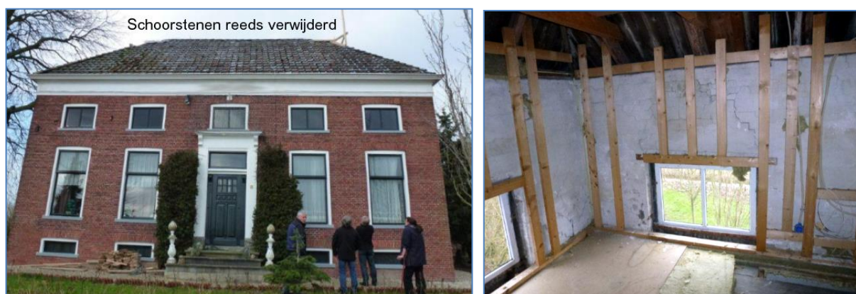
Figuren 9-7. Monumentale boerderij en kopwoning met erg hoge borstwering. De ramen zitten gelijk met de vloer en vormen een verzwakking van die muren. Tussen de muurplaat van de kapconstructie en de zoldervloer zijn origineel geen steunverbindingen. Diagonaal scheuren zijn boven de ramen zichtbaar. De zware schoorstenen zijn reeds uit het dak en zolder verwijderd. De muren zijn tijdelijk met houten delen verstevigd.
