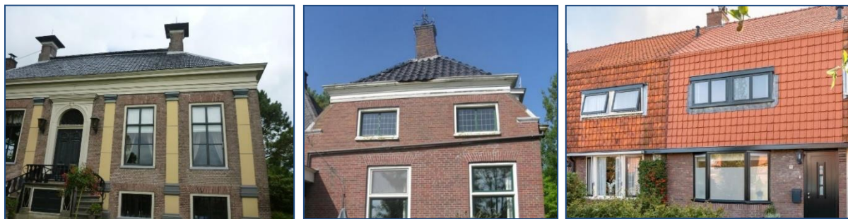
Figuren 9-5. De kapconstructie staat gedeeltelijk op de borstweringen. Links . Hoge borstwering op zolder achter de dakrand en goot. Midden . Kopgevel met lage zolderramen waarbij het dak op ook op een verhoogde borstwering staat. Rechts . Mansardedak met overhang en een binnenzijdige borstwering tot aan de dakramen.
