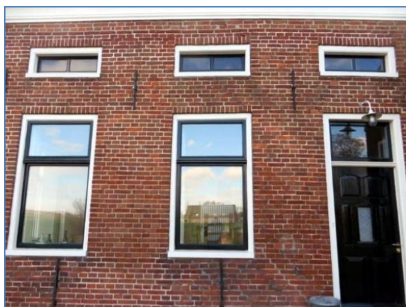
Figuren 9-10. De muur langs de voordeur is naar buiten gekomen. Links. De rechte bovenlijn van de foto laat zien dat het middelste gedeelte van de muur naar buiten is uitgeweken, terwijl de binnen-foto laat zien dat er flinke muurschade is boven de lage ramen. Rechts. De kapspanten zijn wel met een kreupele stijl naar de zoldervloer doorgezet en met ijzeren balkankers aan de steens-buitenmuur verbonden. Echter, de dak-sporen rusten op de muurplaat en het geheel is beweeglijk.
