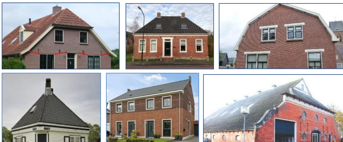
Figuren 9-4. Verschillende dakvormen hebben hun eigen technische problemen. Linksboven . Boerderijwoning met zadeldak en wolfseinde. Midden boven . Schilddak aan vier kanten. Rechtsboven . Mansarde geknikt dak. Onder links . Tentdak, piramidedak. Onder midden . Zadeldak. Onder rechts . Grote schuur dak met uilenbord.
