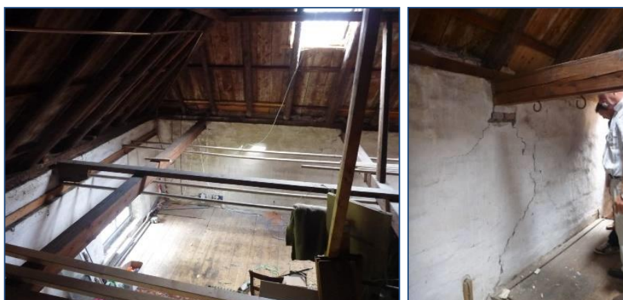
Figuren 9-5. De kapconstructie staat gedeeltelijk op de borstweringen. Links . Hoge borstwering op zolder achter de dakrand en goot. Midden . Kopgevel met lage zolderramen waarbij het dak op ook op een verhoogde borstwering staat. Rechts . Mansardedak met overhang en een binnenzijdige borstwering tot aan de dakramen.
