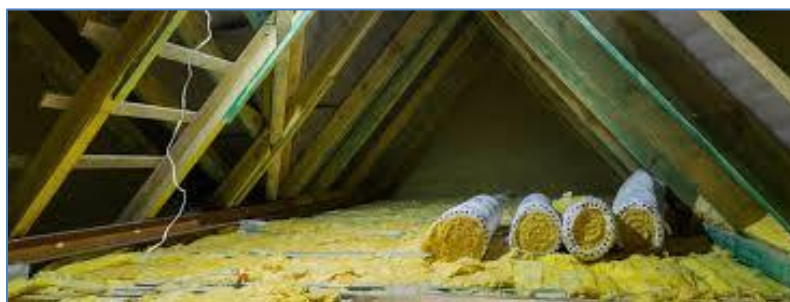
Figuur 9-35. Wanneer de zolder of vliering niet verwarmd hoeft te zijn kan de isolatie op de zoldervloer gelegd. Met een gecacheerde PIR-plaat is de ruimte goed voor opslag te gebruiken. Met samendrukbaar materiaal zoals glaswol of steenwol tussen regels en daaroverheen een multiplex of OSB-topvloer is de vloer voor opslag te gebruiken.
