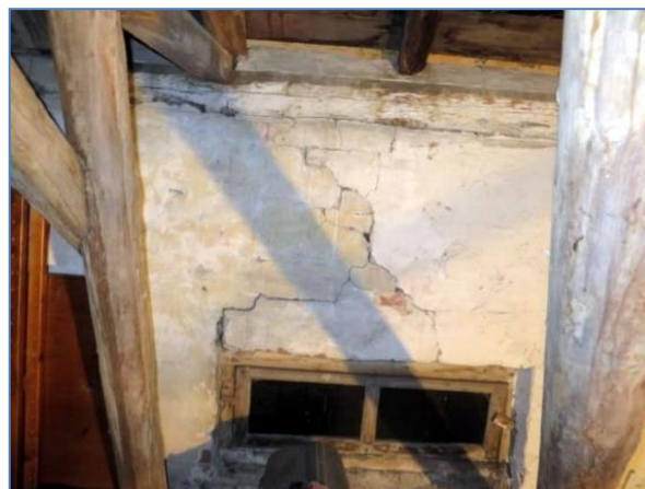
Figuren 9-10. De muur langs de voordeur is naar buiten gekomen. Links. De rechte bovenlijn van de foto laat zien dat het middelste gedeelte van de muur naar buiten is uitgeweken, terwijl de binnen-foto laat zien dat er flinke muurschade is boven de lage ramen. Rechts. De kapspanten zijn wel met een kreupele stijl naar de zoldervloer doorgezet en met ijzeren balkankers aan de steens-buitenmuur verbonden. Echter, de dak-sporen rusten op de muurplaat en het geheel is beweeglijk.
