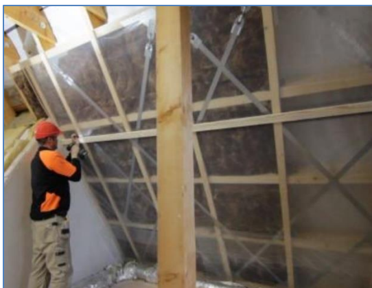
Figuren 9-43. Overzicht van een woonhuis opspanning. Door het aandraaien van een bout kan precies de afstand en de spanning van de diagonalen geregeld worden. Rechts. Hoek verbinding voor vernageling op gezaagde spantdelen.
