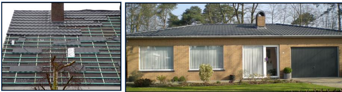
Figuren 9-29. Foto's van Coversys met voorbeelden van lichtmetalen dakbedekking. Voor de bungalow met de erg lage dakhelling is een Ruberoid/EPDM of Dak-folie-PV een andere oplossing voor gewichtsreductie.
