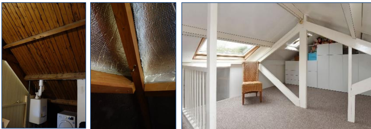
Figuren 9-21. Geen isolatie van daken. Links . Geen isolatie. Midden . Een folie tegen de wind. Rechts . Afgewerkt.
