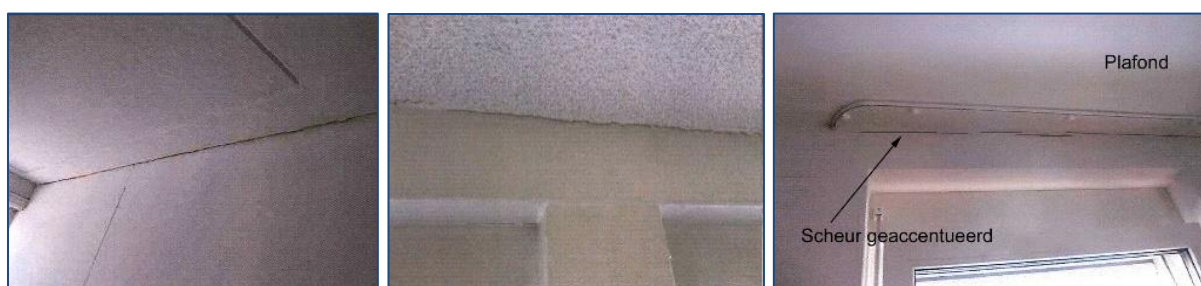
Figuren 8-17. Bij erg veel woningen ontstaan scheuren langs het plafond. De oorzaak is het gebrek aan een vloerdiagramma. Wanneer de scheuren groter worden dan 2 mm is er meestal wat meer aan de hand dan een flexibel diafragma of iets flexibele verbindingen tussen de vloer en de draagmuren.
