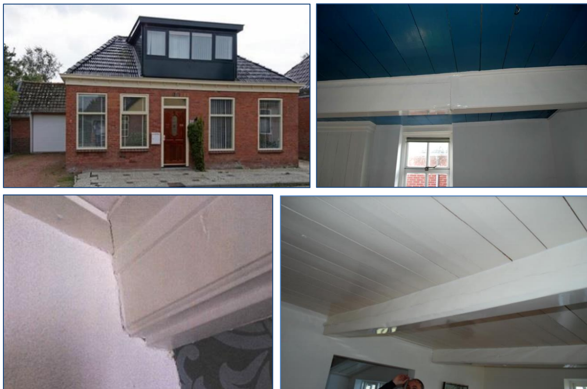
Figuren 8-29. Zwaardere zoldervloerbelasting kan leiden tot het doorbuigen van de balken. Voorbeeld van het in gebruik nemen van een zolder voor bewoning. Slappe balken buigen meer door vanwege de verticale amplitude van de aardbevingsschokken. Het resultaat is dat de plafondbalken millimeters uit de muur worden getrokken ( Links onder ) Dit kan verholpen worden door het versterken van die balken.
