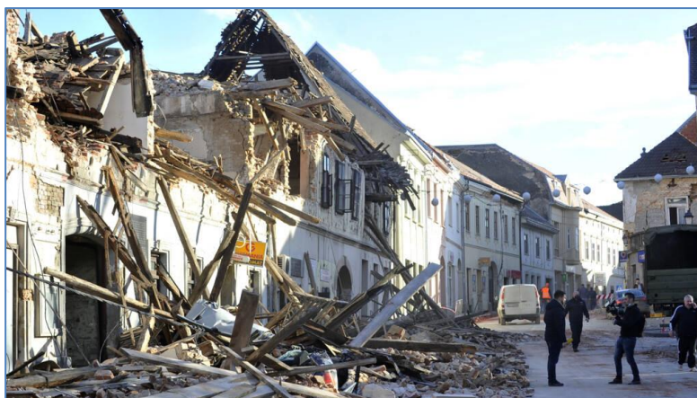
Figuur 8-36. Verankering tussen de balken en de muren was slecht. Bij de recente aardbeving in Petrinja, Kroatië, 06-01-2021 (Richter 4,9) laat het effect zien van onvoldoende verbindingen tussen de constructie onderdelen, met name het gebrek aan het zolder-dak diafragma.
