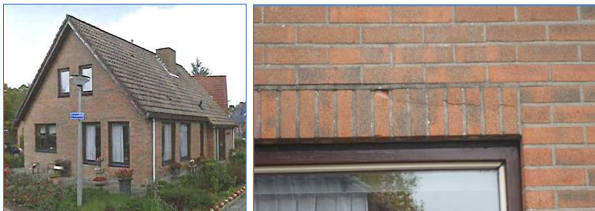
Figuren 7-43. De latei boven het rechterraam, het tweede raam rechts naast de lantaarnpaal.
