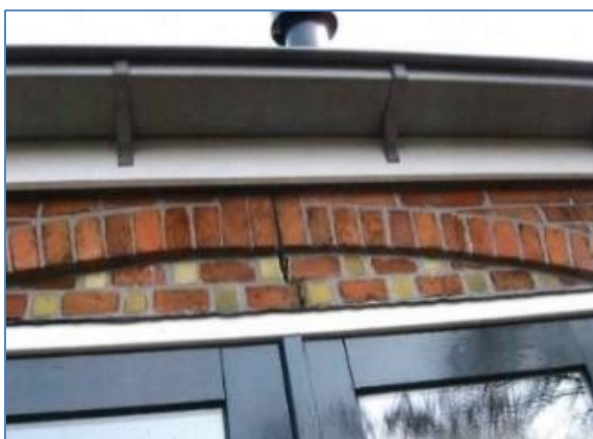
Figuren 7-20. Boven . Nep-latei . Onder : verwijderd en gespleten Boven . Gebroken en verzakt . Onder . Verzakt
