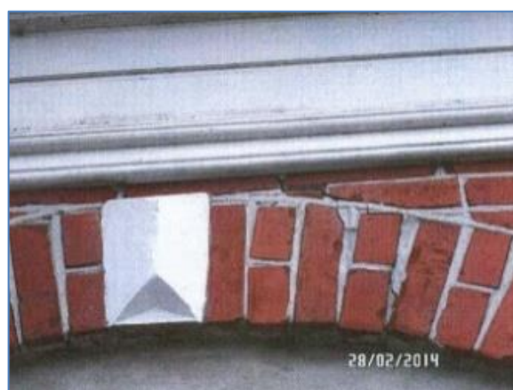
Figuren 7-20. Boven . Nep-latei . Onder : verwijderd en gespleten Boven . Gebroken en verzakt . Onder . Verzakt
