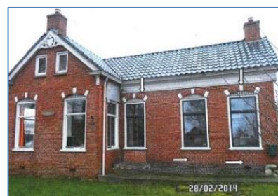
Figuren 7-8. Veel voorkomende typologieën in de provincie Groningen. Per typologie kan een standaard versterkingsmethode en plan voor verduurzaming gemaakt worden, zodat er per individueel gebouw geen eigen en heel tijdrovend en duur rekenprogramma hoeft te worden opgezet. Met inzicht over de algemene seismische problematiek kan een kleine aannemer dan de versterkingen toepassen.
