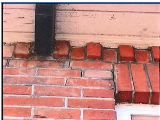
Figuren 7-19. Boven: Rollaag. Onder: Boog
