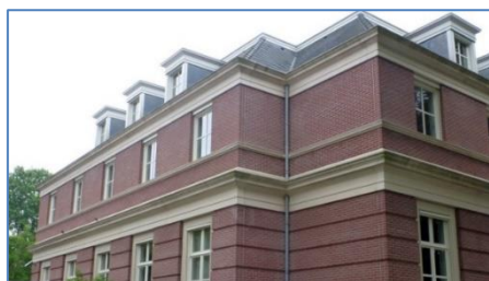
Figuren 7-45. De ringbalken kunnen rondom gepleisterd worden. Op de eerste etage vloer is de balk groter dan op de zolderetage. Het kan goed ingepast worden in de architectuur.
