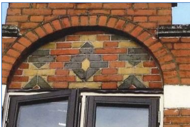
Figuren 7-19. Boven: Rollaag. Onder: Boog
