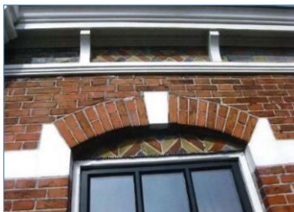
Figuren 7-20. Boven . Nep-latei . Onder : verwijderd en gespleten Boven . Gebroken en verzakt . Onder . Verzakt
