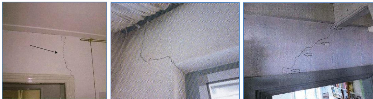
Figuren 7-9. Scheuren in binnenmuren t.g.v. de beving 16-08-2012. De door de schade inspecteurs aanbevolen methode van muurherstel waren slechts cosmetisch.
