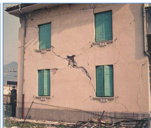
Figuur 6-26. Vier schadevormen aan smalle penanten. Bij een lage boven-belasting scheurt het sneller. Type A is het meest voorkomend. Hoe smaller de penanten, hoe sneller dit gebeurt. Type B ontstaat wanneer een boven- of onderkant van de penant aansluiting versterkt is. Type BC komt veel voor bij een lage bovendruk en een lage afschuivingssterkte.
