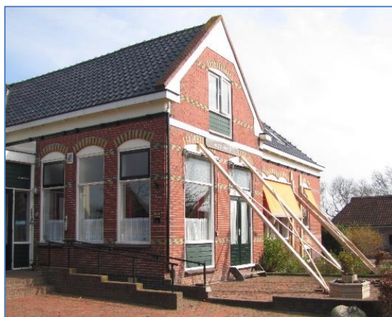
Figuren 6-48. Erg smalle raampenanten is er geen breedte.
