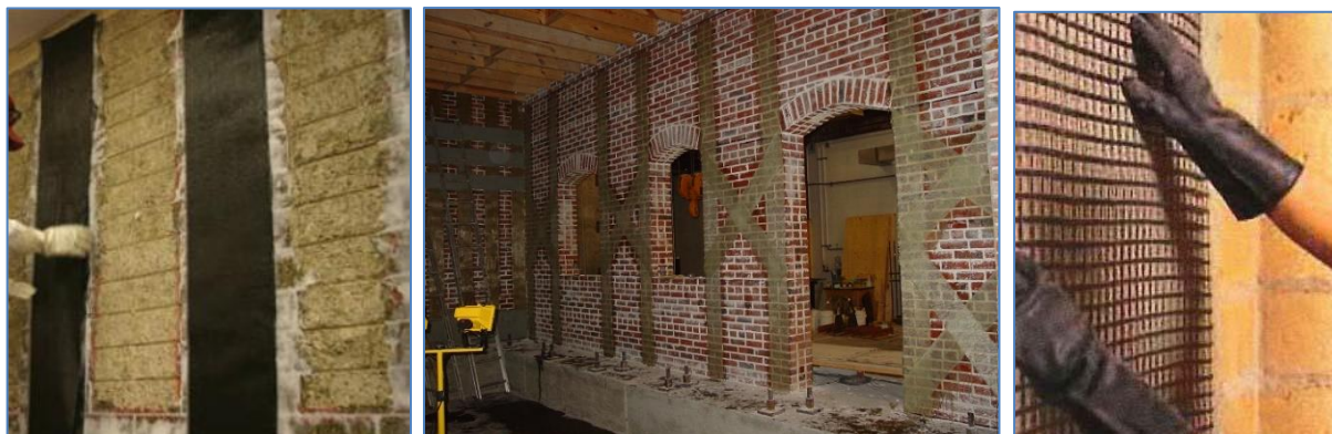
Figuren 6-14. Wapening met Carbonvezel stroken (CRFP) en glasvezelstroken (GVTW). De stroken zijn met epoxy op de muren gelijmd. Glasvezelmatten kunnen met cementmortel/pleister geplakt. Crepi glasvezeldoek wordt ook bij buitenmuurisolatie gebruikt, Polypropyleen banden en glasvezelbehang zijn andere opties. Minischeurtjes worden met het versterkte behang blijvend weggewerkt. Foto's onder.
