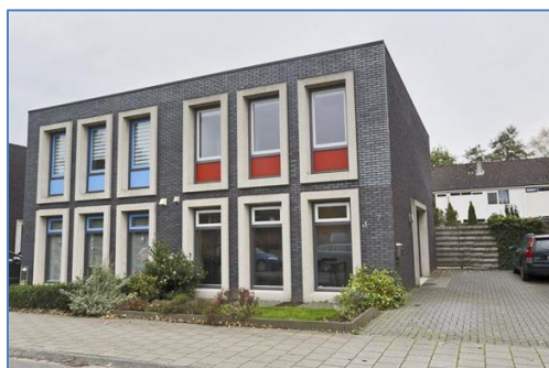
Figuren 6-73. Versterkte raam- of deuroplijstingen.
