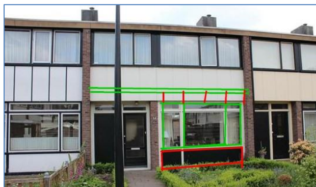
Figuur 6-80. Vervangen van een hele pui met constructief glas. Bij doorzonwoningen is de methode van aanbrengen van constructieve glaspanelen afhankelijk van andere constructie details. In het geval van deze woning moet de borstwering óók versterkt worden om de krachten naar de fundering over te brengen. Daar moet dan wel een fundering zitten!! Ook op de etage moeten maatregelen genomen worden.
