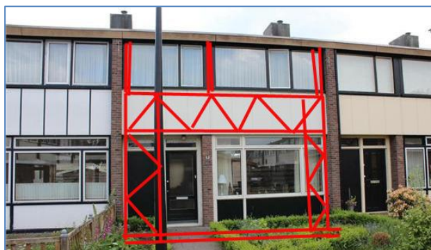
Figuur 6-88. Een metalen frame op een eigen fundering. De 'ligger' achter de borstwering op de eerste etage is momentsterk en vormt een portaal met de verticale delen van het frame. Er vervalt hier dan een smal gevelraam.
