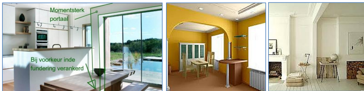
Figuren 6-69. Voorbeelden van portaalconstructies binnen. Portaalconstructies van beton, hout of staal die op de juiste plaatsen zijn gebouwd, zullen de torsiekrachten op de muren sterk verminderen of elimineren..
