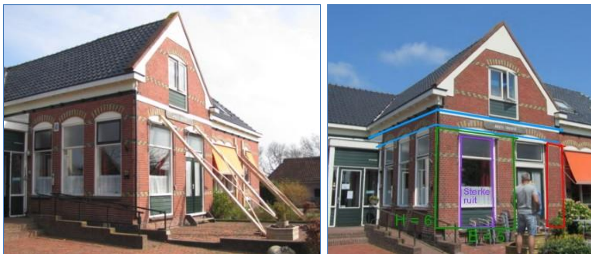
Figuren 6-78. Optie sterke glaspanelen voor gemeenschapshuis Leermens. De raam- en terrasdeur penanten (rood) hebben ongeveer een breedte/hogte verhouding van 1/4,5 = 0,22 en zijn voor een PGAg 0,1 te zwak. Aan de zijkant is het niet beter. De paarse omlijsting geeft de locatie van het glaspaneel aan.
