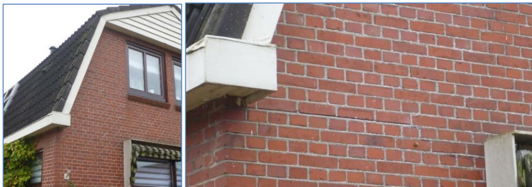
Figuren 6-102. Horizontale scheuren t.g.v. geveltop bewegingen. Het Mansardedak heeft een scharnierscheur tussen de goot en het raam. Deze ontstaat door de beweging van het oude houten dak dat eraan verbonden is.
