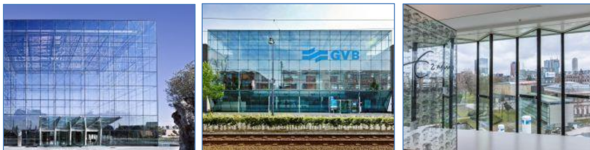
Figuren 6-74. Grote projecten met sterke constructieve ruiten. De ruiten in deze voorbeelden kunnen zeer grote (wind, thermische) belastingen opnemen.
