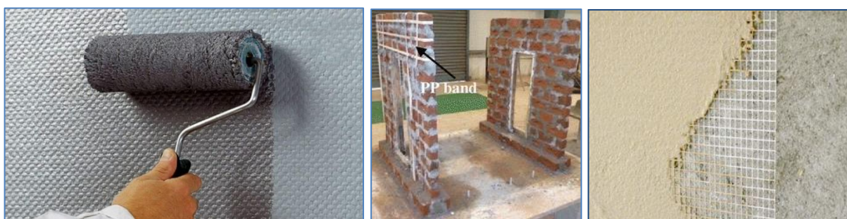
Figuren 6-14. Wapening met Carbonvezel stroken (CRFP) en glasvezelstroken (GVTW). De stroken zijn met epoxy op de muren gelijmd. Glasvezelmatten kunnen met cementmortel/pleister geplakt. Crepi glasvezeldoek wordt ook bij buitenmuurisolatie gebruikt, Polypropyleen banden en glasvezelbehang zijn andere opties. Minischeurtjes worden met het versterkte behang blijvend weggewerkt. Foto's onder.
