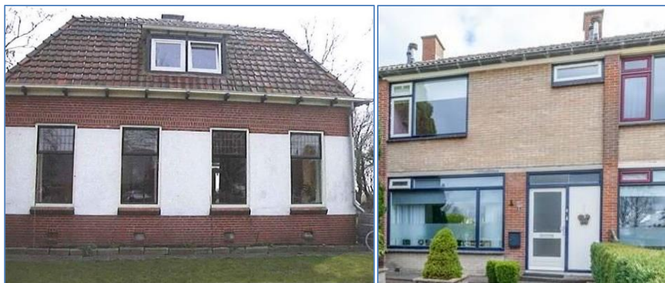
Rechts. Bij deze rijtjeswoning, met extra smalle penanten op de begane grond, moet een andere oplossing gezocht worden om stabiliteit aan het gebouw te brengen (bijvoorbeeld met portalen).
