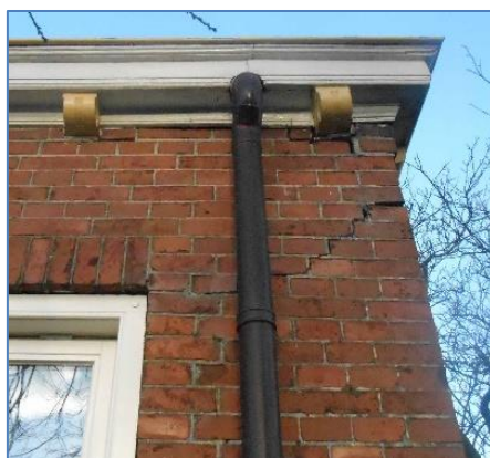
Figuur 6-26. Vier schadevormen aan smalle penanten. Bij een lage boven-belasting scheurt het sneller. Type A is het meest voorkomend. Hoe smaller de penanten, hoe sneller dit gebeurt. Type B ontstaat wanneer een boven- of onderkant van de penant aansluiting versterkt is. Type BC komt veel voor bij een lage bovendruk en een lage afschuivingssterkte.
