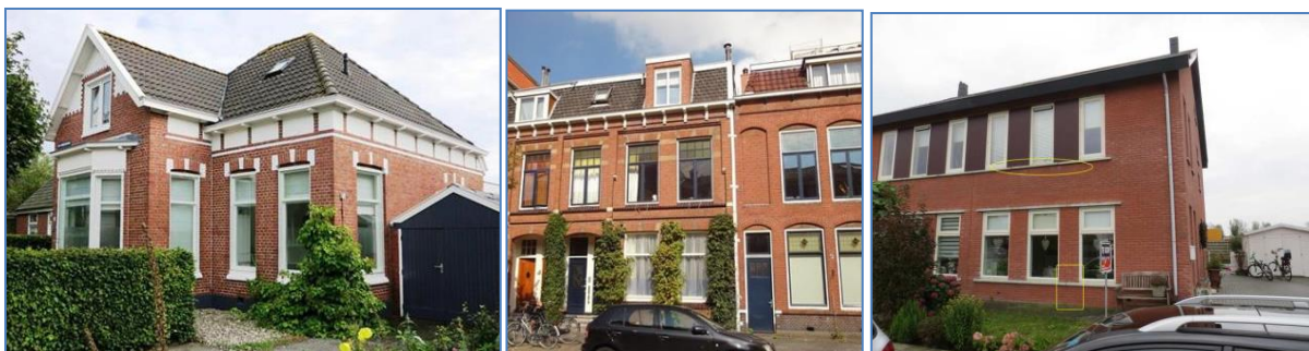
Figuren 6-30. Veel woningen hebben smalle penanten. Zowel woningen daterend uit rond 1900 met steens muren als naoorlogse woningen met spouwmuren hebben smalle penanten die bij een zijwaartse schok kunnen kantelen. Rechts . De gele markeringen bij deze nieuwe woning geven aan waar horizontale scheuren onder en boven in de penanten ontstonden bij een PGAg 0,06.
