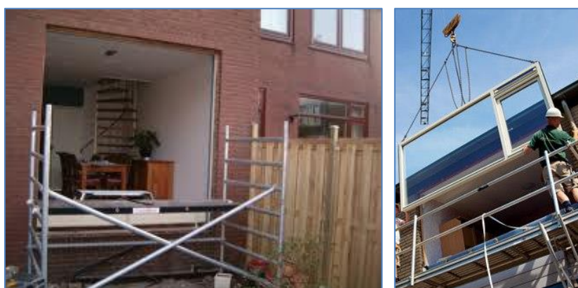
Figuren 6-85. Buitenzijdige versterking en verduurzaming. Voorbeeld van aanpassing van de gevel terwijl de bewoners in het gebouw verblijven. Deze methode is zinvol voor woningbouwcorporaties waar grote series woningen moeten worden verduurzaamd.
