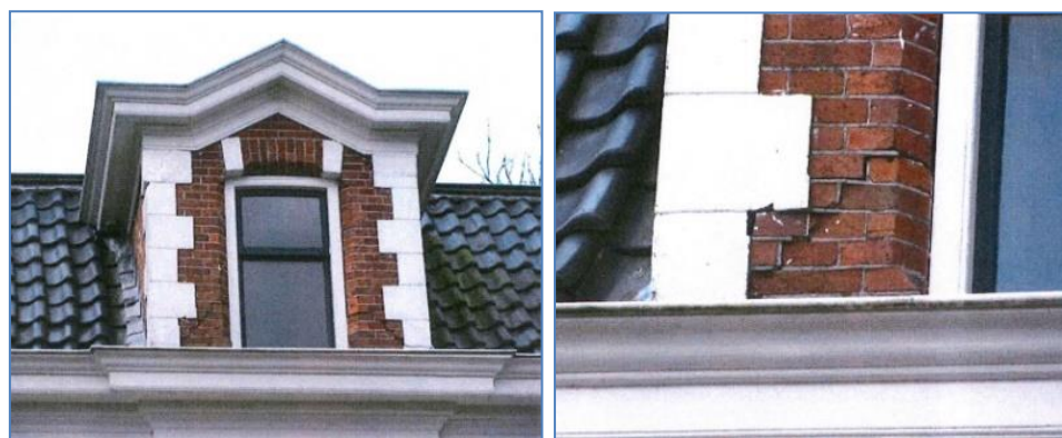
Figuren 6-32. Diagonaalscheur en verschuiving loodrecht op het vlak van de muur . De massa van de bakstenen dakkapel is ook ietsje naar voren gekomen (afschuiving).
