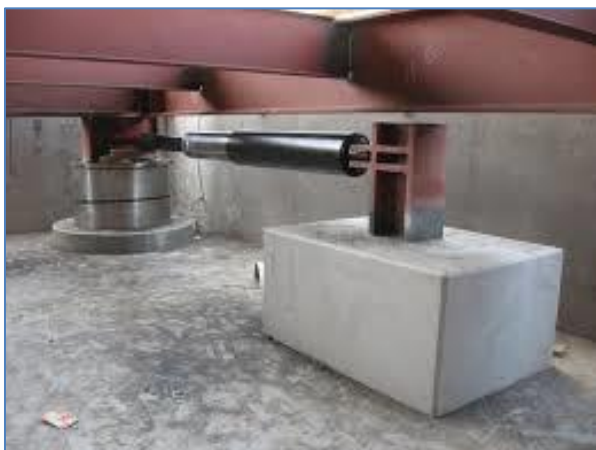
Figuren 5-12. Schokdempers (viscose weerstand) tussen de onderste en de bovenste fundering. Deze horizontale schokdempers voorkomen dat stormwinden lichte of hoge gebouwen te veel doen trillen of bewegen. De sterkte van de schokdempers kan worden bijgesteld.
