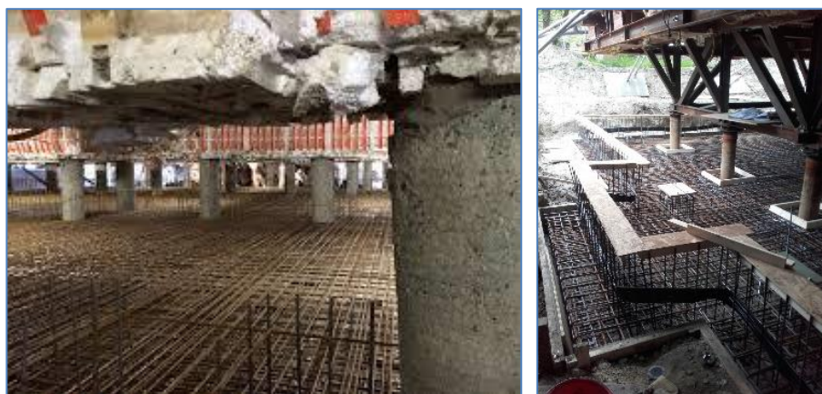
Figuren 5-21. Aanleg van een platformfundering en sterke balken fundering.
