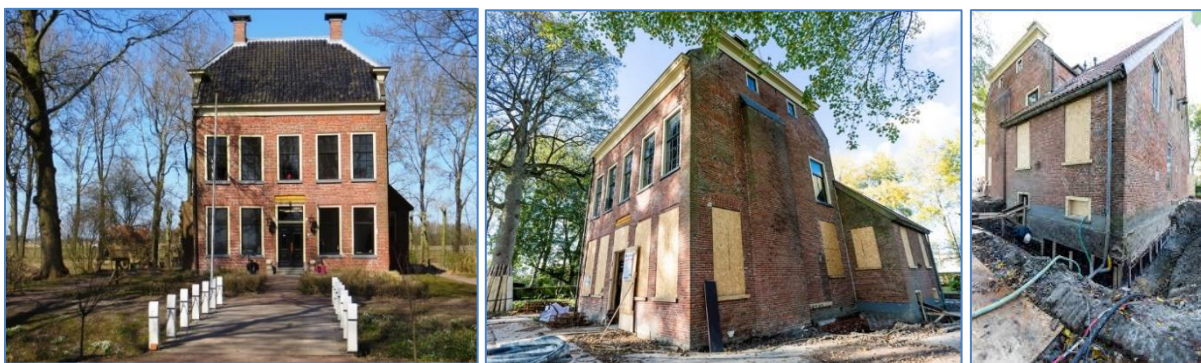
Figuren 5-8. Base-isolation inclusief kelder van de Borg Rusthoven (1686) in Wirdum.
