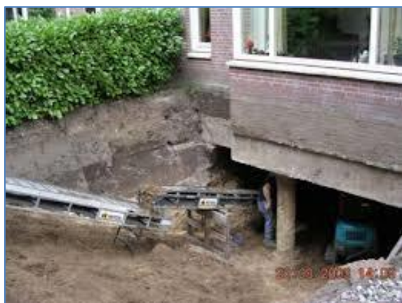
Figuren 5-35. Schets voor de installatie van een paalkop Base-isolation. De vrij gegraven paalfundering is toegankelijk voor het aanpassen van de paalkoppen wanneer de fundering tijdelijk ondersteund wordt.
