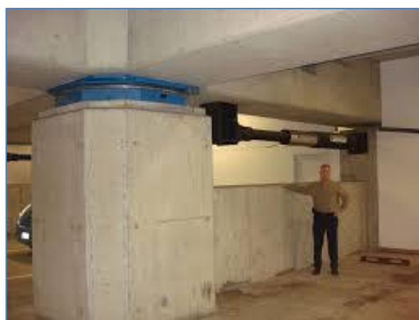
Figuren 5-12. Schokdempers (viscose weerstand) tussen de onderste en de bovenste fundering. Deze horizontale schokdempers voorkomen dat stormwinden lichte of hoge gebouwen te veel doen trillen of bewegen. De sterkte van de schokdempers kan worden bijgesteld.
