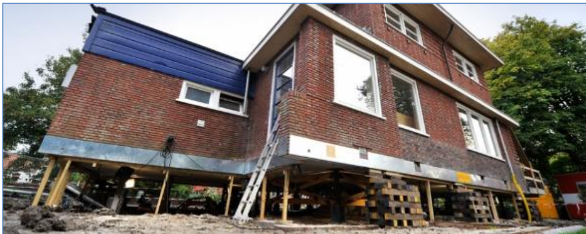
Figuur 5-3. Deze jaren '30 pastorie-woning in Garrelsweer 6 werd in 2017 voorzien van een betonvloer boven-fundering en 1 m opgetild (250 ton). Hierna werd een platform onder-fundering aangelegd en een Base-isolation op korte palen geïnstalleerd. Dit houdt nog geen thermische isolatie in, of opwaarderen naar NOM of BENG. Over de kosten werden geen mededelingen gedaan. Deze acties waren eigenlijk meer dure testcases om te kijken in hoeverre Base-isolation bij woningen kon worden toegepast. Praktisch gesproken was het niet noodzakelijk, gezien de werkelijke PGA.
