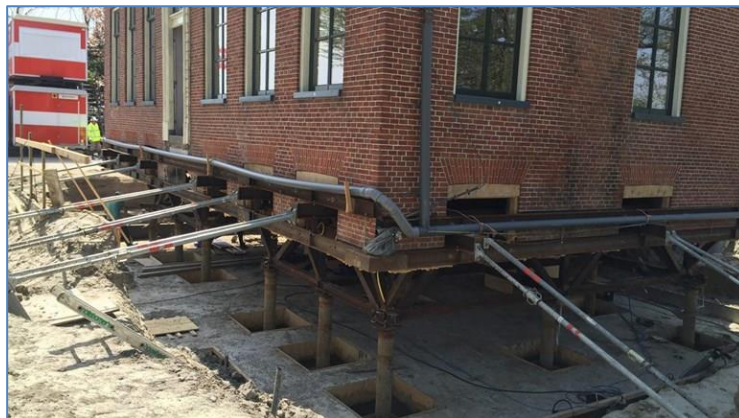
Figuur 5-11. Het rijksmonument de Maarlandhoeve te Uithuizen (1839). Dit gebouw werd als eerste Base-isolation project met perspalen opgekrikt. Daarna werd er op de Base-isolation en nieuwe platformfundering gezet, waarna de perspalen werden verwijderd. De plaatfundering garandeert een waterpas en geheel zetting-vrije basis.
