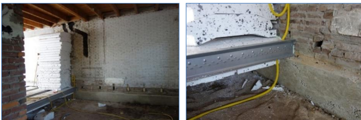
Figuren 4-23. Renovatie met verwijderde houten vloer.
