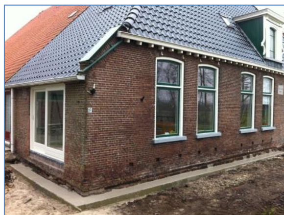
Figuur 4-55. Basis voor een isolerende buitengevel. Op de betonbalk rondom kan eventueel een nieuwe geïsoleerde en sterke buitengevel kan worden geplaatst. Bij een extra buitenzijdige isolatie moet soms het dak-overstek en de goten worden aangepast.
