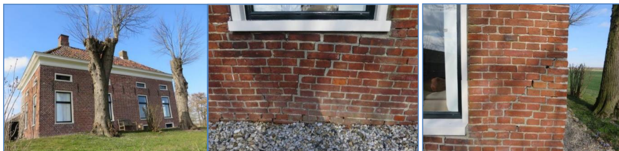
Figuren 4-15. Serie foto's van een oude boerderij op een terp met bomen. Overzicht en detailfoto's zijn van de linke gebouw hoek genomen. Door de kalkmortelvoegen is er eerst een vervorming ontstaan. Toen de vervorming te groot werd ontstonden er scheuren. In een vroeg stadium zijn de voegen dichtgesmeerd. Deze scheuren zijn groter geworden.
