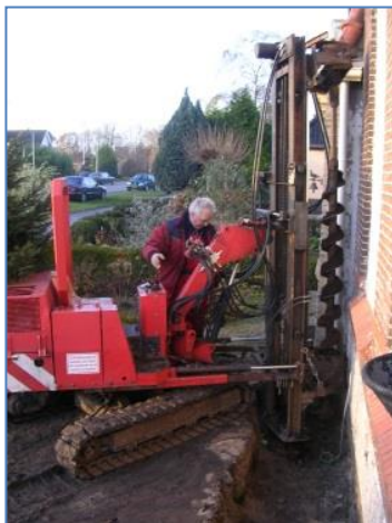
Figuren 4-54. Schroefpaal of boorpaal wordt langs de gevel ingebracht.
