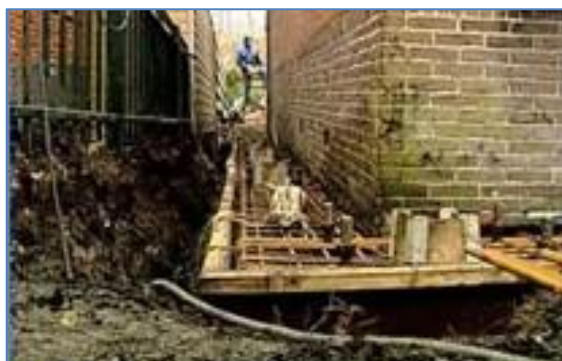
Figuren 4-53. Voorbeelden van buis-perspalen (de Waal) Deze worden direct onder een muur geplaatst worden. Hiervoor wordt er een sleuf uit de muur gezaagd.
