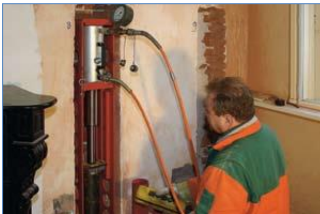
Figuren 4-53. Voorbeelden van buis-perspalen (de Waal) Deze worden direct onder een muur geplaatst worden. Hiervoor wordt er een sleuf uit de muur gezaagd.
