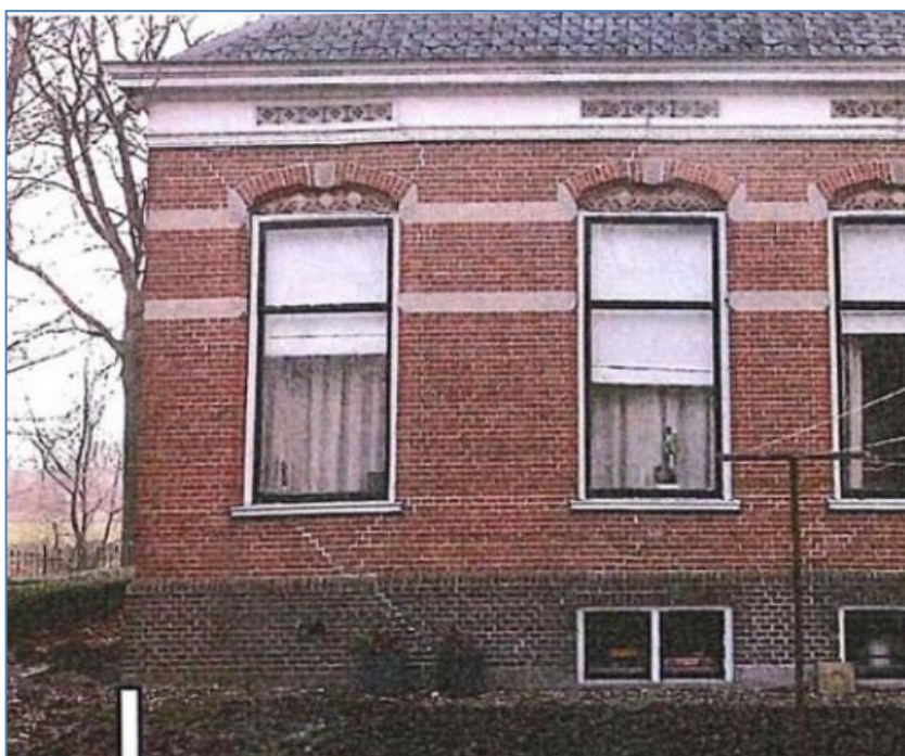
Figuren 4-27 Kelder scheuren Boven. Bij een stijve vloer in combinatie met een kleine dieperliggende kelder, zal het niet-onder-kelderde gedeelte van de fundering verbreed moeten worden vóórdat seismische versterking of verduurzaming van dat gebouw kan worden gerealiseerd.
