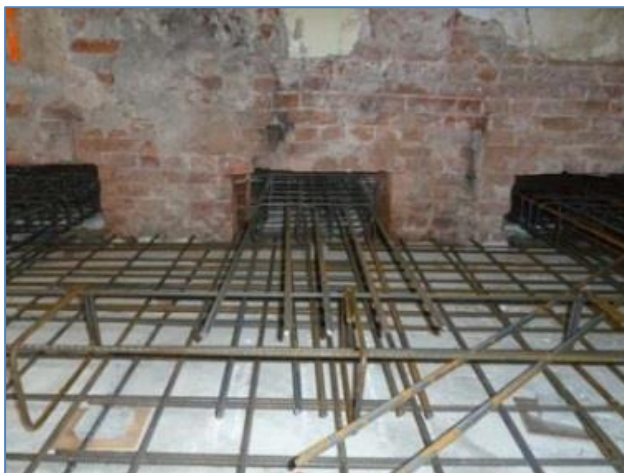
Figuur 4-64. Aanbrengen van de wapening op de gasbetonvloer.
