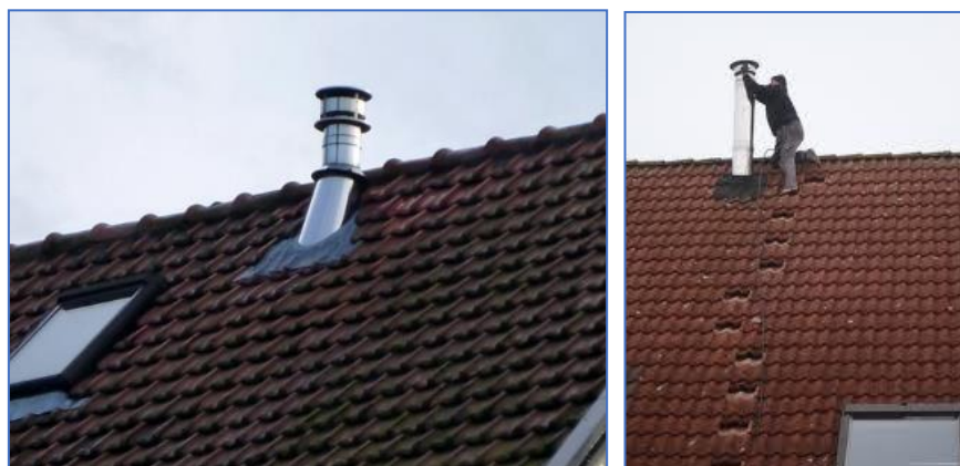
Figuren 3-18. Roestvrij stalen geïsoleerde pijpen.
