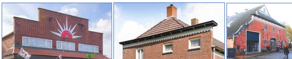
Figuren 3-64. Vrije zijhoeken van geveltoppen zitten alleen aan de onderzijde vast. Links . Zeer hoog risico. Midden . Hoog risico voor de hoeken. Rechts . Zeer hoog risico omdat de achterliggende schuur erg flexibel is.
