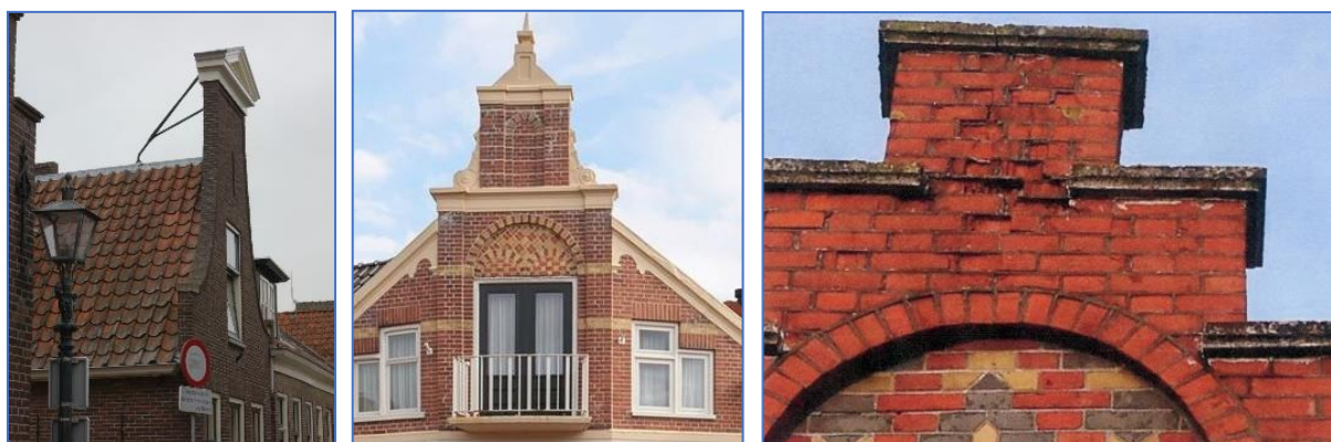
Figuren 3-63. Verschillende modellen geveltoppen. Links . Verankerd maar risicovol. Midden . Vrijstaand, extra hoog en risicovol. Rechts . Aanzienlijk verweerd en risicovol.
