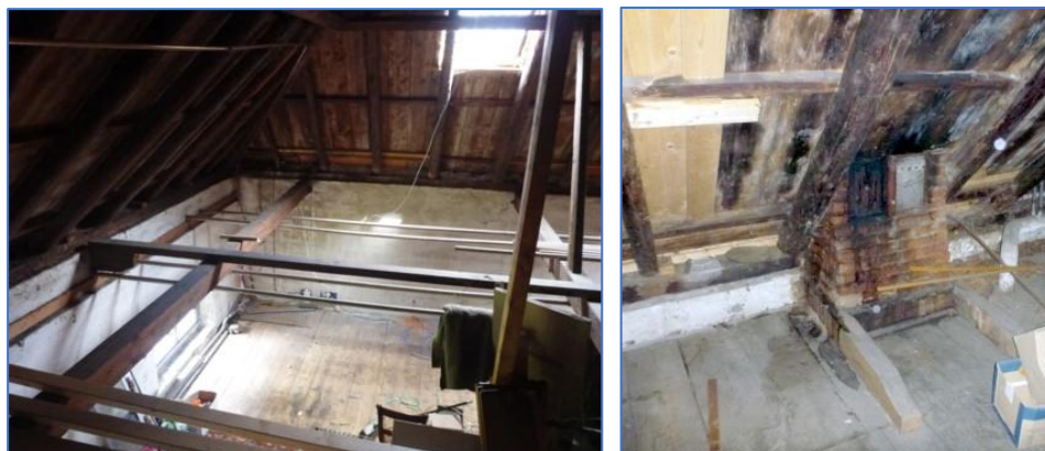
Figuren 3-72. Hoge borstwering met spanbanden verbonden.
