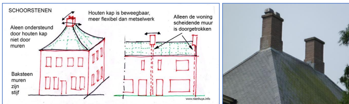
Figuren 3-30. Schoorsteen op wolfseinde en flexibele houten kapconstructie.
