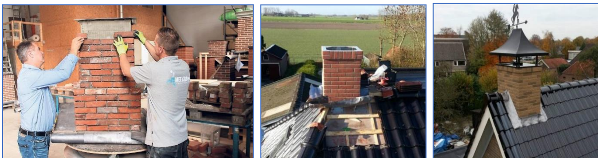
Figuren 3-60. Montage van een monumentale steenstrip-schoorstenen. Deze hebben een 70% gewichtsbeporing ten opzichte van de originele schoorsteen. Midden en rechts. Wolfseinde van een dak, composiet >80% gewichtsbeporing; schoorsteen met kap.
