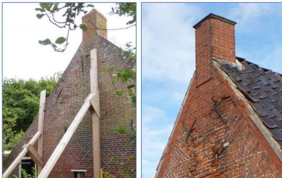
Figuren 3-26. Kopgevel schoorstenen op een steens en halfsteensmuur.
