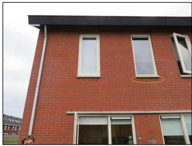
Noordgevel aan tuinkant (slecht zichtbaar). Kop platen dragen in de binnenmuren deze kant.
