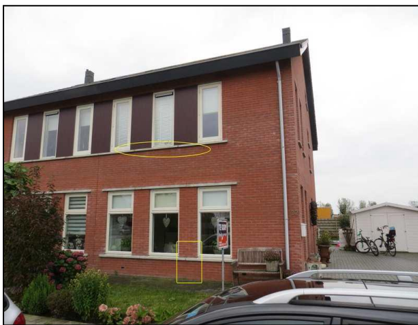
Zuid gevel aan straatkant (slecht zichtbaar). Vloerplaten liggen van links naar rechts.
