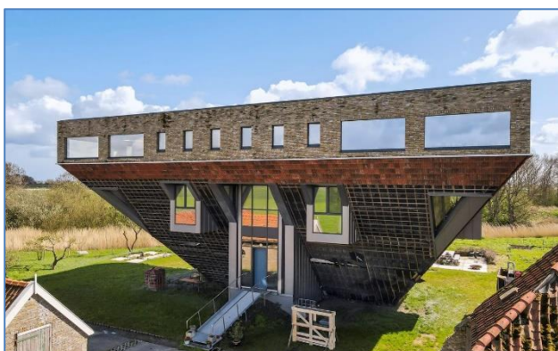
Figuren 2-2. Niet regelmatige vormgeving gebouwen. Het is technisch mogelijk om onregelmatige bouwwormen toe te passen, maar de interne constructie en fundering moet dan seismisch aangepast worden. Links boerderij Workum, Rechts . Belvédère Hilversum.
