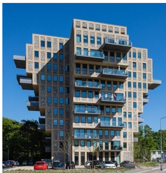
Figuren 2-2. Niet regelmatige vormgeving gebouwen. Het is technisch mogelijk om onregelmatige bouwwormen toe te passen, maar de interne constructie en fundering moet dan seismisch aangepast worden. Links boerderij Workum, Rechts . Belvédère Hilversum.
