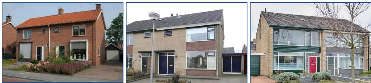
Figuren 2-55. Twee-onder-een-kap-woningen. Verschillende modellen uit verschillende periodes met weinig of helemaal geen penanten of dwarsmuren
