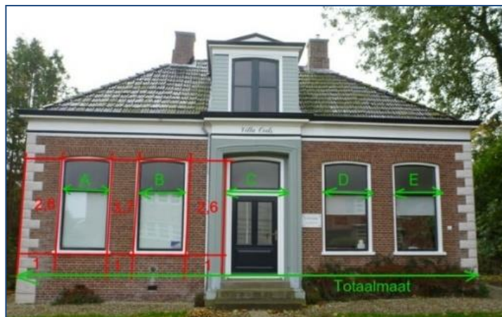
Figuur 2-44. Bepaling van de verhoudingen van openingen in de gevel.
