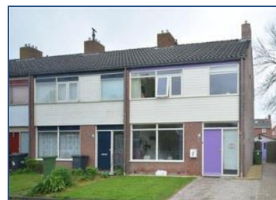
Figuren 2-56. Rijtjeswoningen in verschillende soorten. Vanaf de buitenkant kan slechts een schatting gemaakt worden van de afmetingen van de dragende penanten, terwijl sommige gebouwen herkenbaar zijn als stapelbouw (rechtsboven). Plattegronden helpen bij het bepalen van de aanwezige dwarsmuren. Als er intern open keukens zijn gemaakt, verhoogt dit de problematiek. Woningcorporaties hebben meestal de bouwtekeningen.
