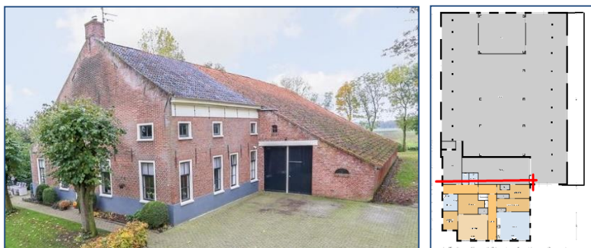
Figuren 2-21. Geen stijve verbinding tussen kop en de schuur.
