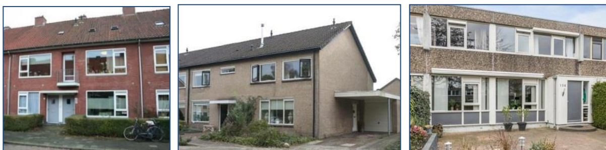
Figuren 2-56. Rijtjeswoningen in verschillende soorten. Vanaf de buitenkant kan slechts een schatting gemaakt worden van de afmetingen van de dragende penanten, terwijl sommige gebouwen herkenbaar zijn als stapelbouw (rechtsboven). Plattegronden helpen bij het bepalen van de aanwezige dwarsmuren. Als er intern open keukens zijn gemaakt, verhoogt dit de problematiek. Woningcorporaties hebben meestal de bouwtekeningen.
