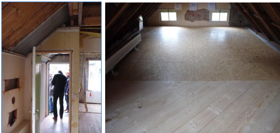
Figuren 6. Schuin plafond gedeelte bij de voordeur en in oude keuken. Rechts. Versterkte zoldervloer maar geen extra woonruimte gecreëerd.
