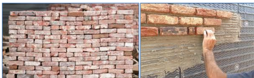
Figuren 12-15. Baksteen recycling en plakken van steen-strips.
