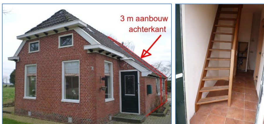
Figuren 7. Deze woning was al door de eigenaar van achten uitgebreid. Rechts. Van binnen was de open trap naar zolder slechts 60 cm breed, en de doorgang ernaast ook.
