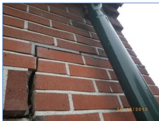
Figuren 3. Voorzijde met eerder gevelherstel en positie septic-tank naast de voordeur. Achtergevel met balkon, en bijkeukendeur. Verzakkingsschade in de hoek van de bijkeuken.
