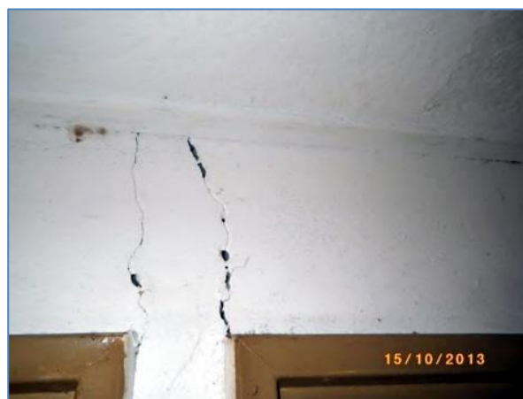
Figuren 4. Zowel nieuwe als oude scheuren rondom het gebouw werden fotografisch vastgelegd. Verse scheuren hebben scherpe en schone randen.
