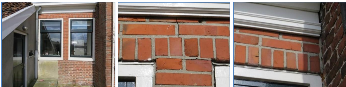
Figuren 39. Een lage aanbouw naast een hoger of ouder hoofdgebouw zal bijna altijd een scheur op de aansluiting ontstaan.
