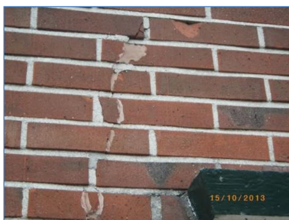
Figuren 4. Zowel nieuwe als oude scheuren rondom het gebouw werden fotografisch vastgelegd. Verse scheuren hebben scherpe en schone randen.
