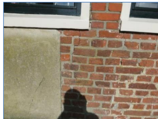
Figuren 39. Een lage aanbouw naast een hoger of ouder hoofdgebouw zal bijna altijd een scheur op de aansluiting ontstaan.
