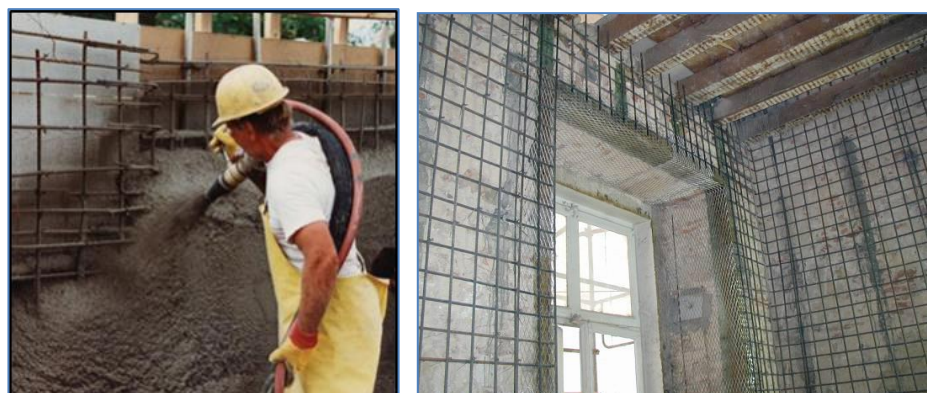
Figuren 29. Spuitbeton. Foto's 2011, door Appleton
