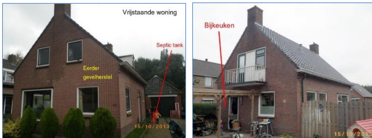
Figuren 3. Voorzijde met eerder gevelherstel en positie septic-tank naast de voordeur. Achtergevel met balkon, en bijkeukendeur. Verzakkingsschade in de hoek van de bijkeuken.
