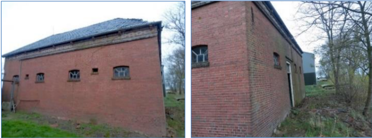
Figuren 40. Deze serie foto's van een grote schuur met gescheurde achter- en zijgevel laten zien dat het funderingsprobleem van deze uitgebreide schade dierct verband heeft met het uitzakken van de rechterzijde van het gebouw door de daar aanwezige sloot rechts.
