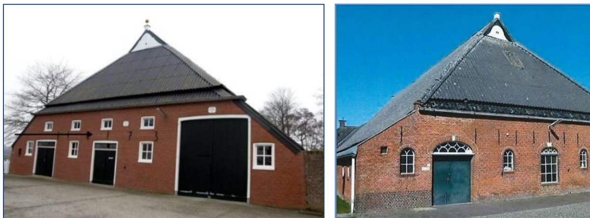
Figuren 10-23. De mezzanine vloer zit aan de massieve kopgevel verankerd. De verankering is met een serie grote muurankers aan de buitenkant. Links . Ramen geven licht op de vloer van de mezzanine. Rechts : Hier zijn er geen ramen op de mezzanine, wel de ankers.
