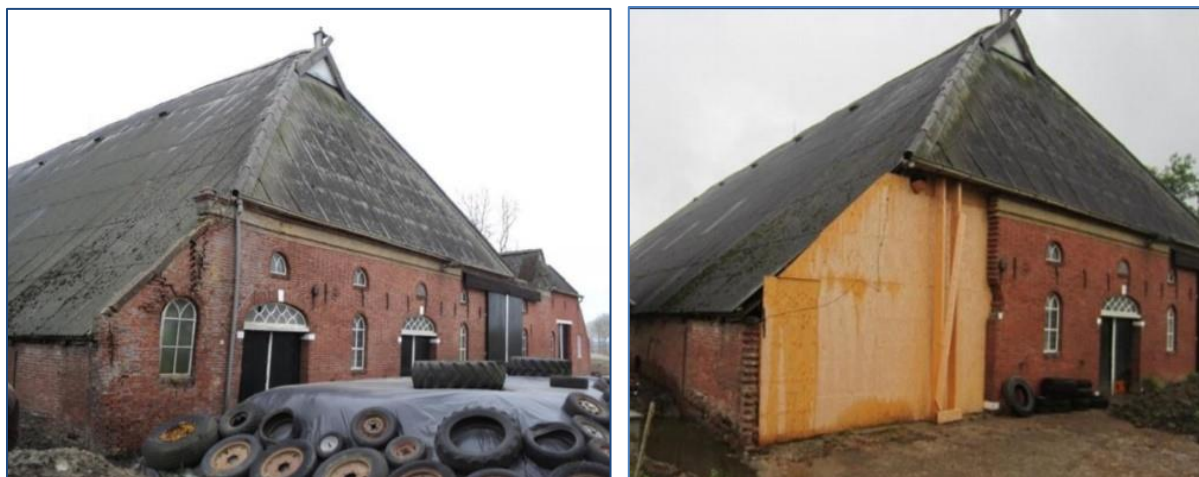
Figuren 10-34. Complexe schadesituaties. In sommige situaties is het verval en de schade zo complex dat geheel slopen en dan opnieuw opbouwen de enige optie is. Links . Oude situatie. Rechts . Na de sloop klaar voor gedeeltelijke reconstructie. Het betreft hier een cultureel erfgoed dat op na het melden van aardbevingschade hersteld werd. Ook is het hier duidelijk dat dit geen recent probleem was.
