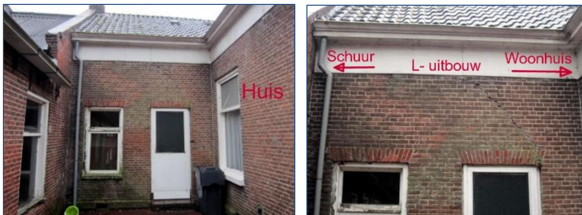
Figuren 10-6. Kop-hals-romp boerderij met schade. Boven de deur loopt een grote scheur naar linksboven. De schuur (links) heeft het hals-gedeelte naar beneden getrokken. Dit wijst op zowel een slechte fundering van de schuur, als een slechte fundering van de hals. Rechtsboven . De top van de gevel is verbreed. Er is geen doorgaande latei boven de ramen. Een verbetering zal dus (A) een dilatatie moeten inhouden én (B) een verbetering van de fundering én (C) het aanleggen van een verbindend dak-diafragma van het woonhuis met doorgaande latei buitenom.
