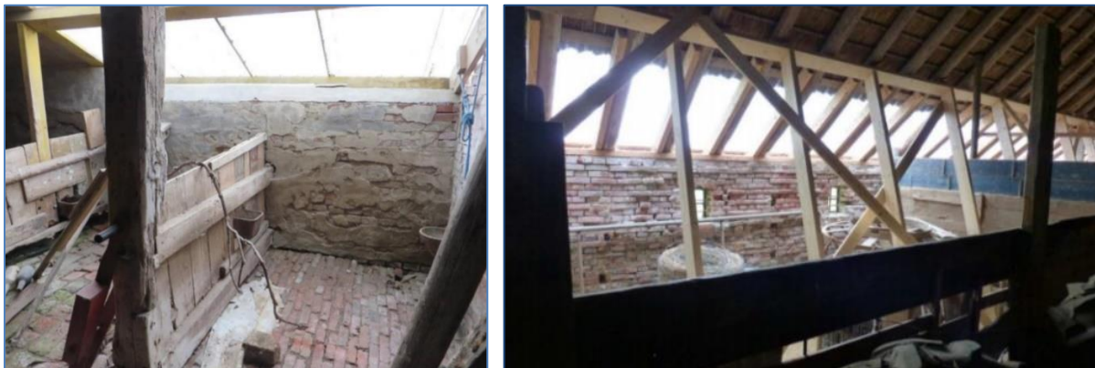
Figuren 10-38. Oude kalveren stallen werden vervangen. Links. Oude kalveren boxen. Rechts. De dak-sporen worden boven de binnenmuur ondersteund met schoren. Wanneer deze ruimte weer gebruikt gaat worden kunnen hier licht doorlatende platen op gelegd worden.
