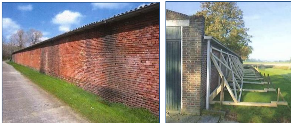
Figuren 10-36. Tegen de lange en lage muren zijn vaak de koeienstallen aangelegd. Langs de daken zijn niet altijd goede goten aanwezig is. Het vele regenwater zakt weg in de grond naast de matige funderingen.
