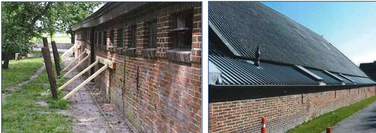
Figuren 10-36. Tegen de lange en lage muren zijn vaak de koeienstallen aangelegd. Langs de daken zijn niet altijd goede goten aanwezig is. Het vele regenwater zakt weg in de grond naast de matige funderingen.
