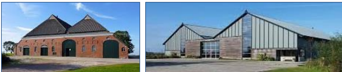
Figuren 10-26. Het vervangen van de hele gevel van de grote schuur. Dit kan niet wanneer de schuur een monumentenstatus heeft.
