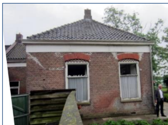
Figuren 10-6. Kop-hals-romp boerderij met schade. Boven de deur loopt een grote scheur naar linksboven. De schuur (links) heeft het hals-gedeelte naar beneden getrokken. Dit wijst op zowel een slechte fundering van de schuur, als een slechte fundering van de hals. Rechtsboven . De top van de gevel is verbreed. Er is geen doorgaande latei boven de ramen. Een verbetering zal dus (A) een dilatatie moeten inhouden én (B) een verbetering van de fundering én (C) het aanleggen van een verbindend dak-diafragma van het woonhuis met doorgaande latei buitenom.
