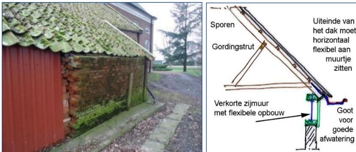
Figuren 10-41. Ingestort muurdeel vervangen door lichtmetalen afscherming.
