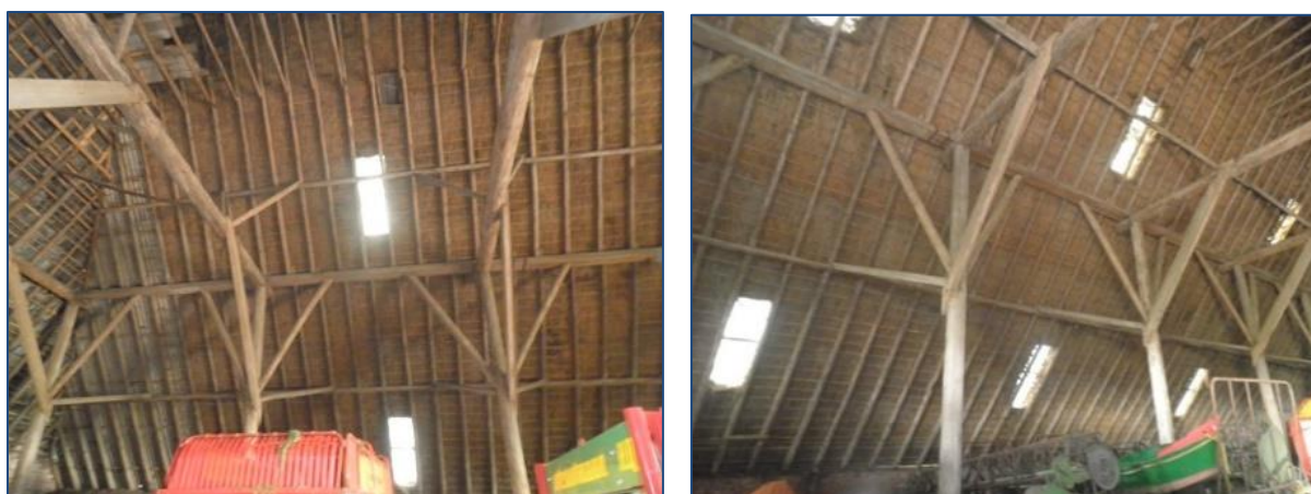
Figuren 10-19. De gebintenschuren worden voor opslag gebruikt. Hier zit onder de asbestcement golfplaten nog een laag riet dat voor wat isolatie zorgt. Het dak is hier helemaal van rondhout gemaakt met vrij lichte gebinten.
