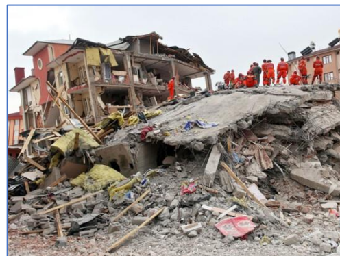
Figuren 1-35. De slechte situatie met stijve vloeren en dunne flexibele kolommen.
