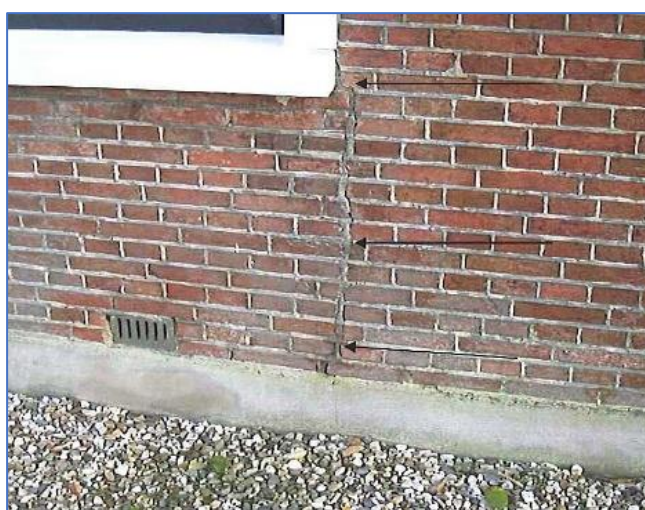
Figuren 1-37. Legio scheuren ontstaan vanuit de fundering vanwege kleine zettingen.
