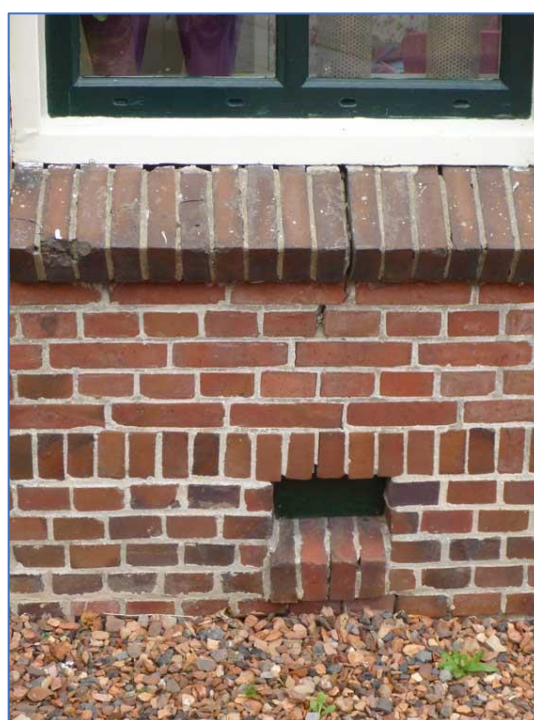
Figuren 1-37. Legio scheuren ontstaan vanuit de fundering vanwege kleine zettingen.
